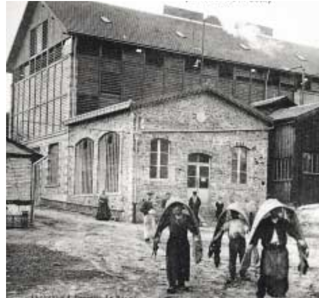
En haut : Tannerie Gasnier-Fondeur à Château-du-Loir. En bas : La fonderie de Cordé.
